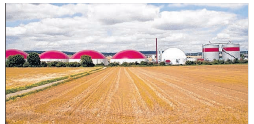
Ovag-Biogasanlage in Berstadt.
