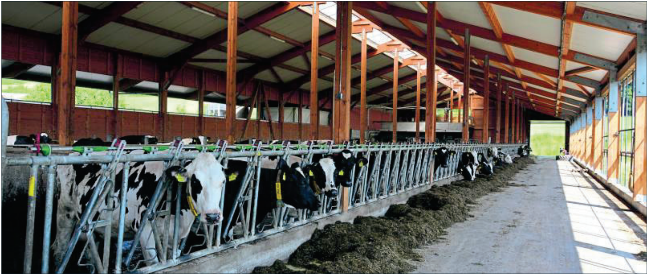
Auf dem Hof Meindroth in Hofaschenbach wurde vor knapp fünf Jahren der Stall neu gebaut. Er lässt sich rechts vollständig öffnen, so bekommen die Tiere Luft. Fotos: Lea Marie Kläsener
